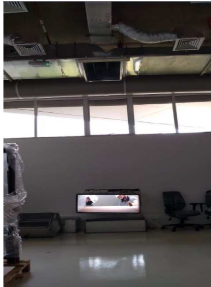
Figura 14 – Sala 442E2 – Duto em desmontagem
